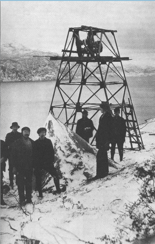
Bildet er fra byggingen av kraftlinjen fra Flørli til Oltedal i 1917 - 1918. Arbeiderne er i ferd med å oppføre en spennmast på Helle-siden for kryssing av Høgsfjorden.
