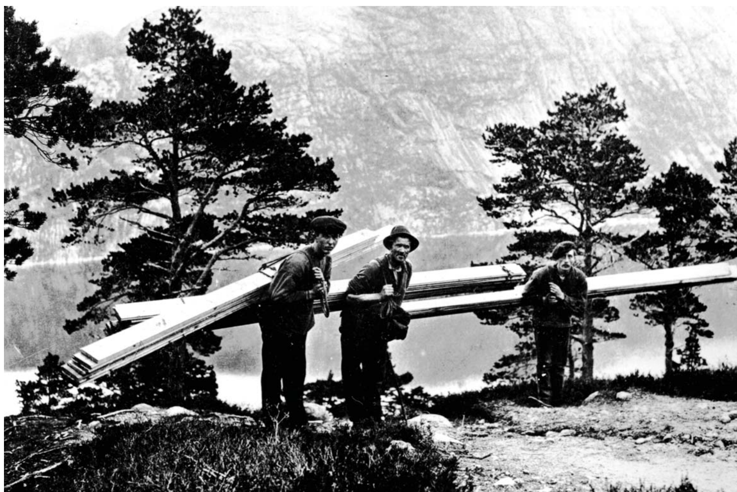
Blodslit og svette er lagt til grunn for å bygge ut en sikker elektrisitetsforsyning i Sør-Rogaland.
