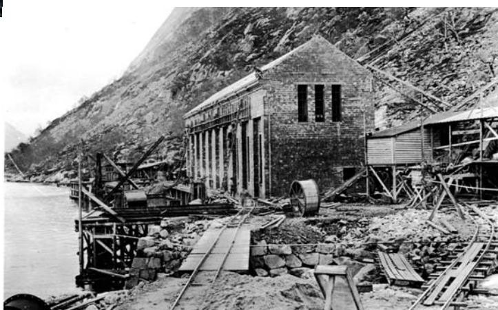
Kraftverket i Flørli var et privat initiativ, og skulle etter planen dekke kraftbehovet for et planlagt smelterverk i mellomkrigsårene. Planene ble aldri noe av. Kraftverket kom i stedet til å bli helt sentralt i forsyningen av elektrisitet til Stavanger i mellomkrigsårene. Etter veldig tøffe forhandlinger som stadig brøt sammen, kjøpte Stavanger kommune anlegget 1. januar 1927. Bildet er fra 1917.
