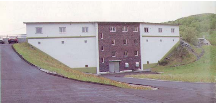
Renseanlegget ved Langevatn ble offisielt åpnet i 1959. Det spesielle med konstruksjonen var at selve renseanlegget ble bygget inn i demningen.
