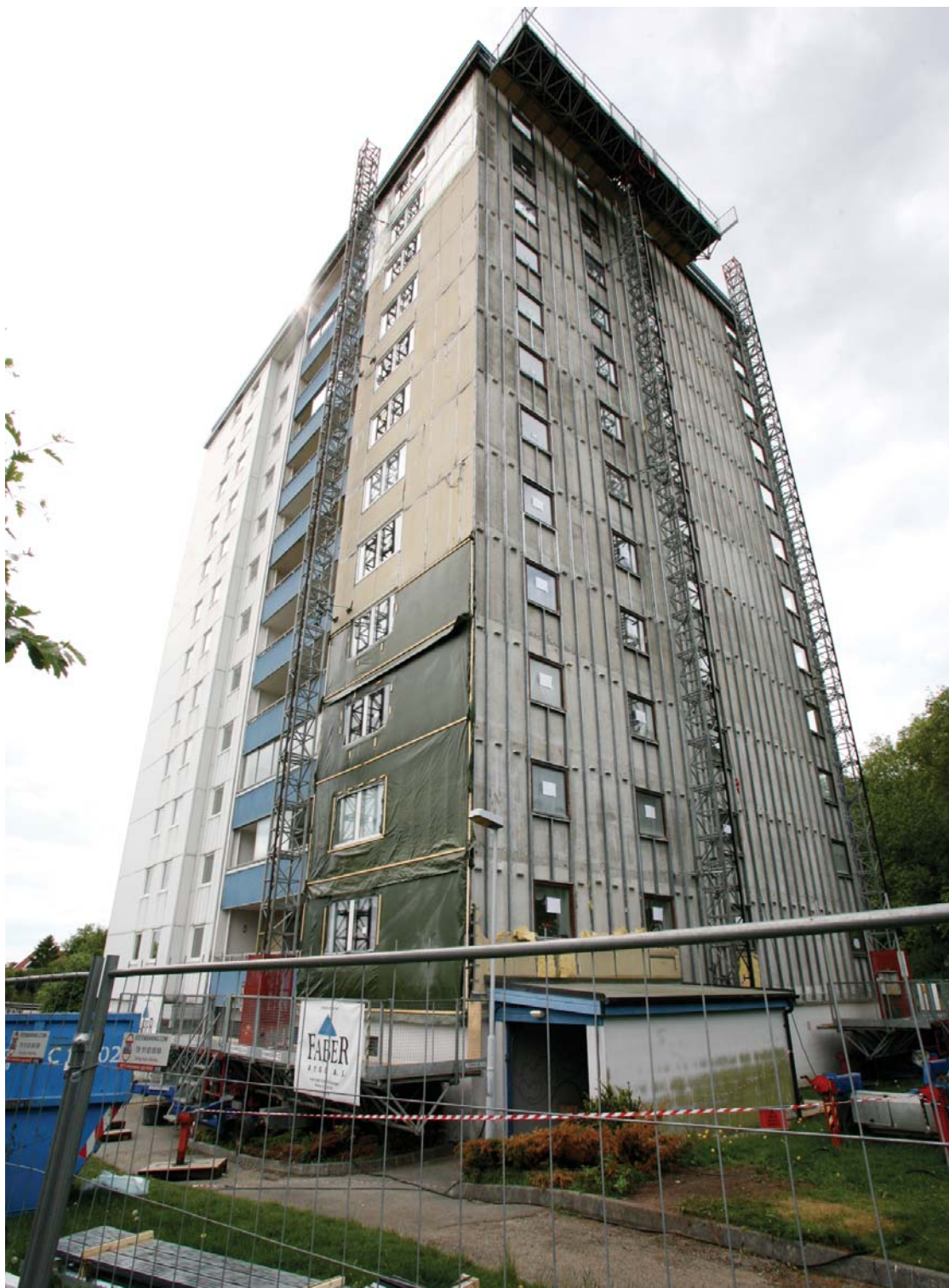
Gandsfjord borettslag skal få en ansiktsløfting. Det er lokale Faber Bygg som gjør jobben, og de tar den nederste blokken først for å sanke erfaringer før de gyver løs på de to neste.
