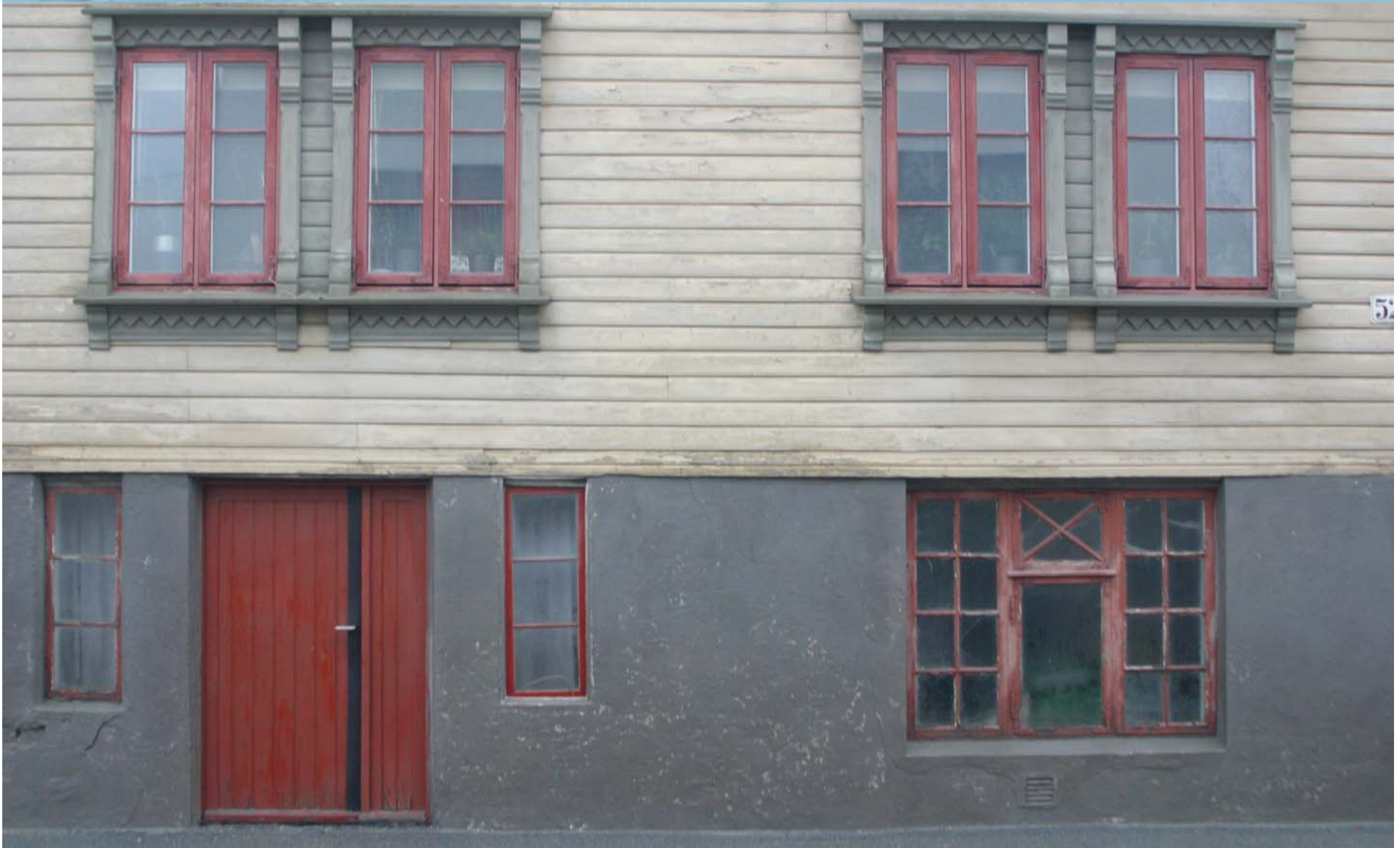
En typisk husfasade i Strandgaten. Bak alt asfaltstøvet skjuler det seg en perle fra den tiden hest og kjerre dominerte i gaten.
