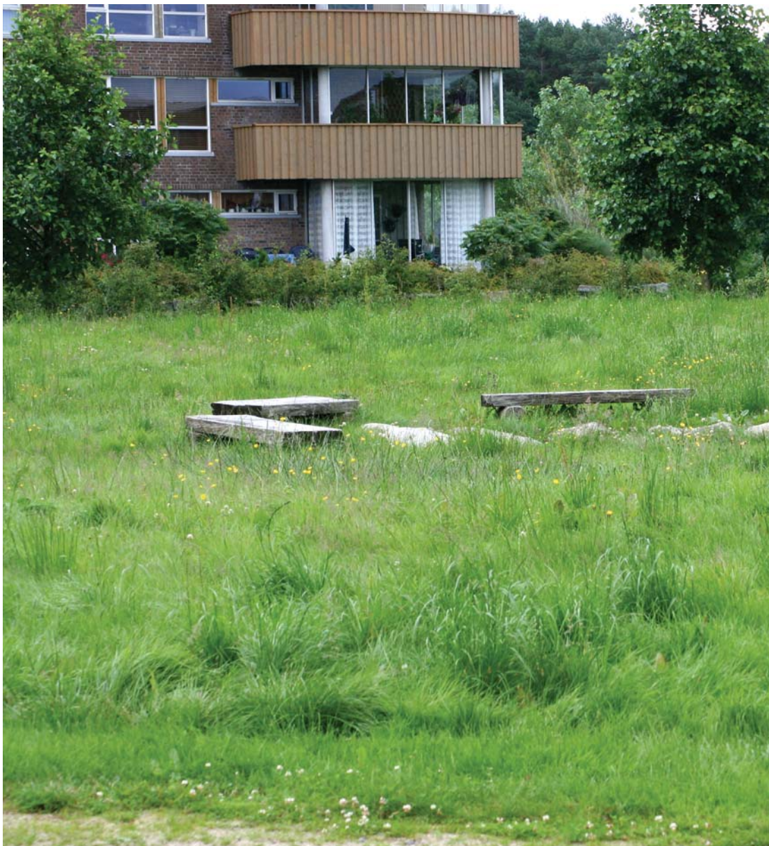
Mangelen på vedlikehold er begynt å bli synlig i Smeaheia.
